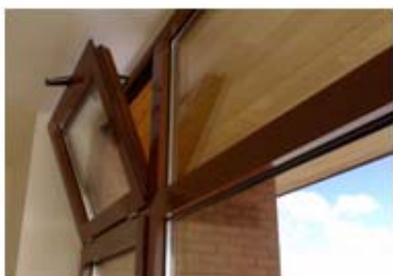
Větrání v bytech a domech
