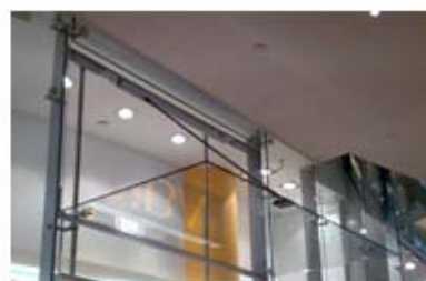
Celoskleněné RWA klapky dle ČSN EN 12 101,2
