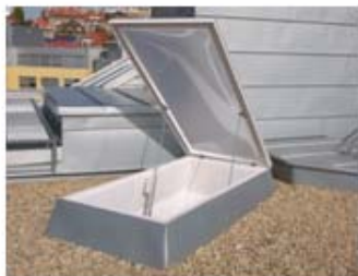
Světlíky a okna pro odvětrání chráněných únikových cest
