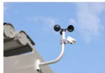
Automatizace větrání např. detektory větru a deště
